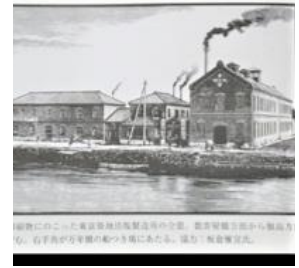
東京築地活版製造所
